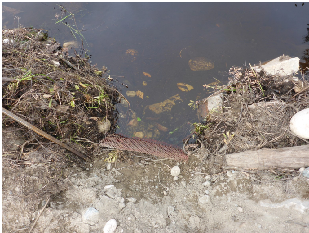
Photo 38 Grille du ponceau à l'entrée du segment S03, cours d'eau CE15 (2017)
